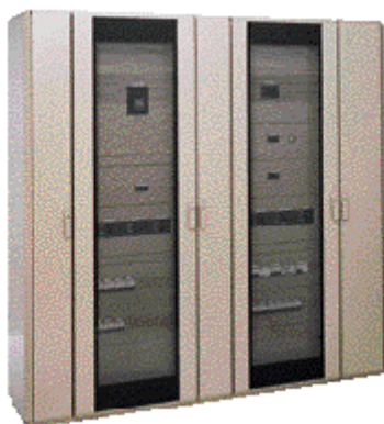
Figura 13 VISTA DE ARMARIO DOBLE YA TERMINADO
